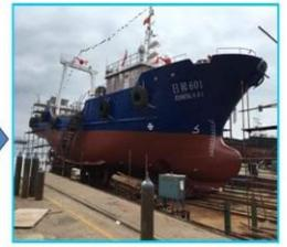
2016年2月20日, 14艘渔船在山东石岛黄海造船厂(10艘拖网)、荣成造船厂(2艘拖网)、威海东海造船厂(2艘围网)开工建造。2016年5月中旬完成全部14艘渔船分段的合拢, 标志着主体结构已经完工。
